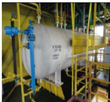
Sistema de drenagem fechada.
